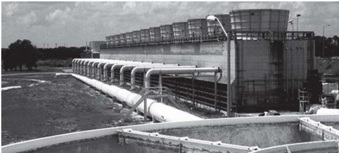
**Foto 1.1.- Torres de enfriamiento de gran tamaño, con estructura de concreto
